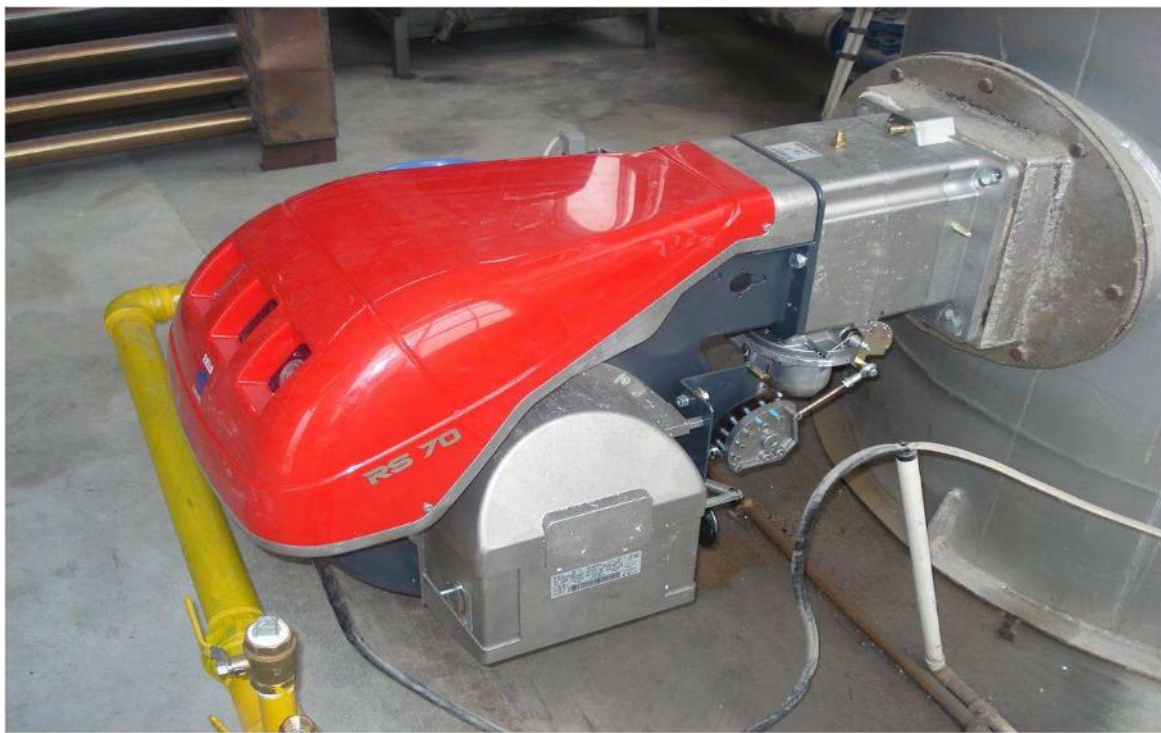
图 6.2-1 在燃烧设备上安装的低氮燃烧器实例
