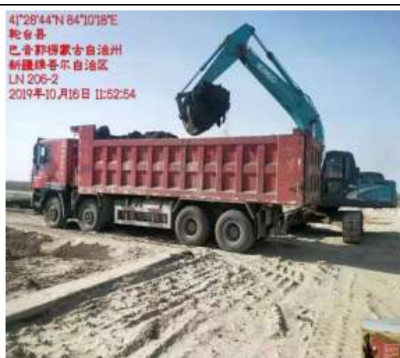
清理岩屑池的施工现场
