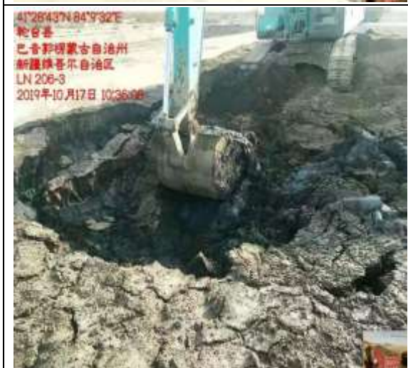
清理岩屑池的施工现场
