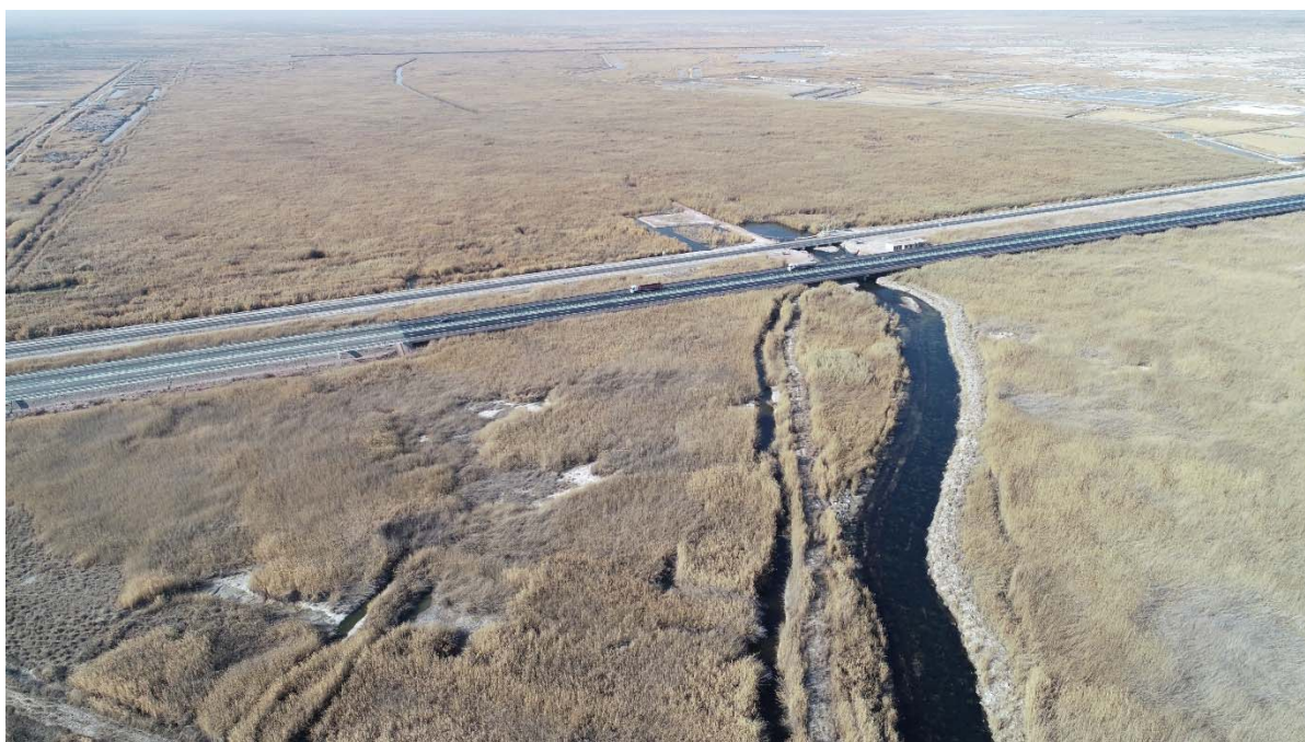
图 4.1-1 管道黄水河穿越点地形地貌照片
