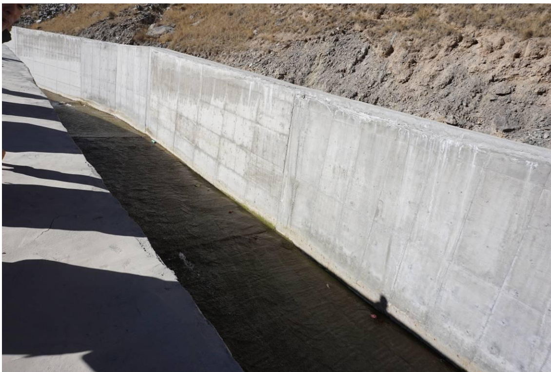
图 2.4-12 乌鲁木齐河改道新建排洪渠（6m×8m）
