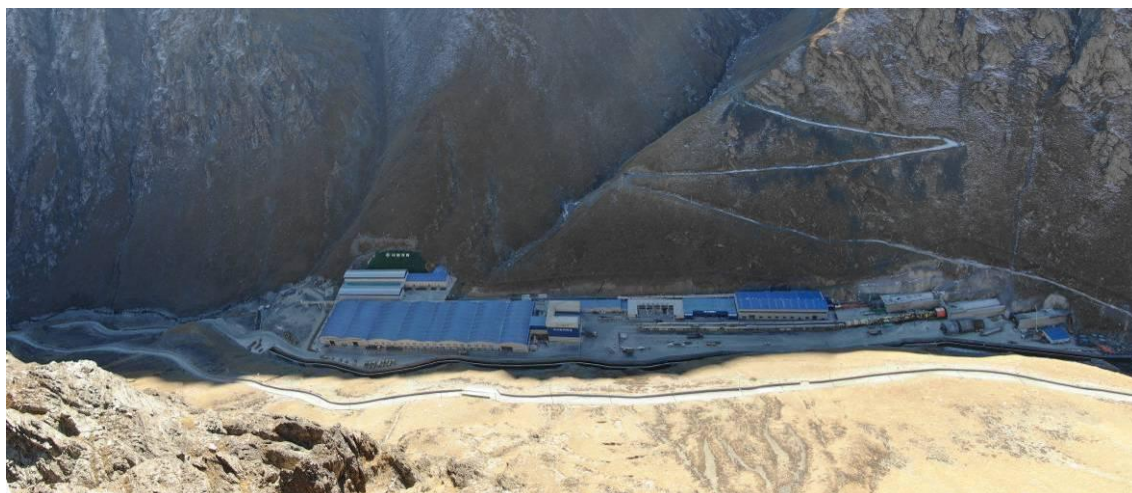
图 2.4-2 K75+000-K75+900 隧道进口综合营地
