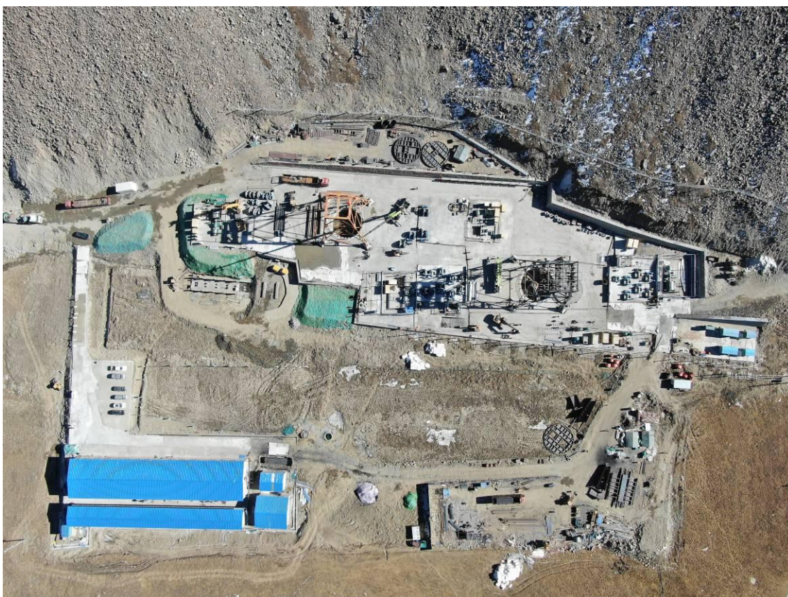
图 2.4-4 YK80+360 1#竖井综合营地
