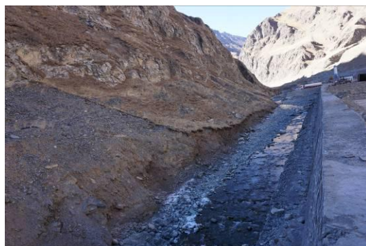
临河预制场挡墙
