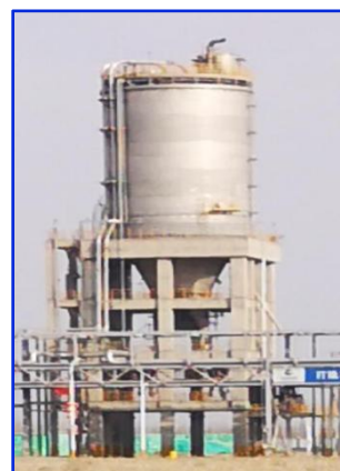
散装料仓排气筒
