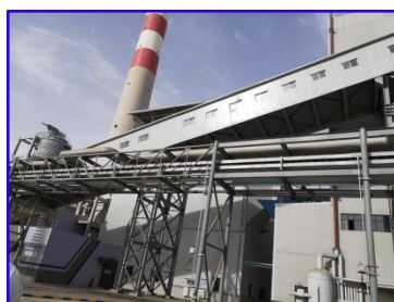
封闭式输煤栈道
