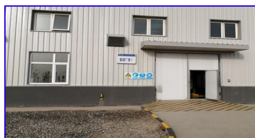
污水处理站中水回用系统超滤车间
