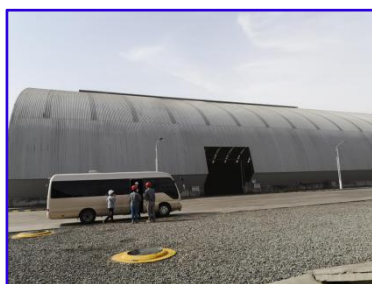
封闭式储煤场
