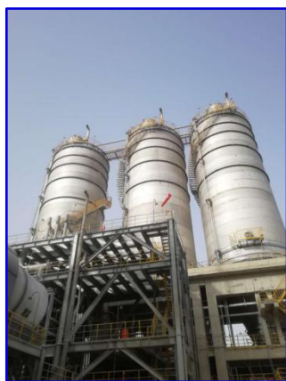
班料仓排气筒
