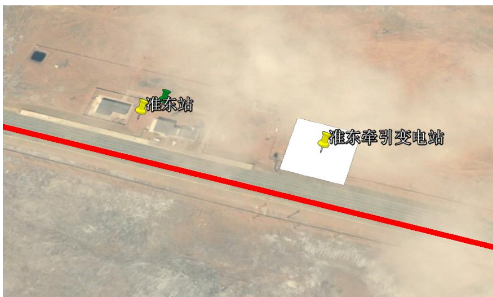
淮东新建牵引变电站
