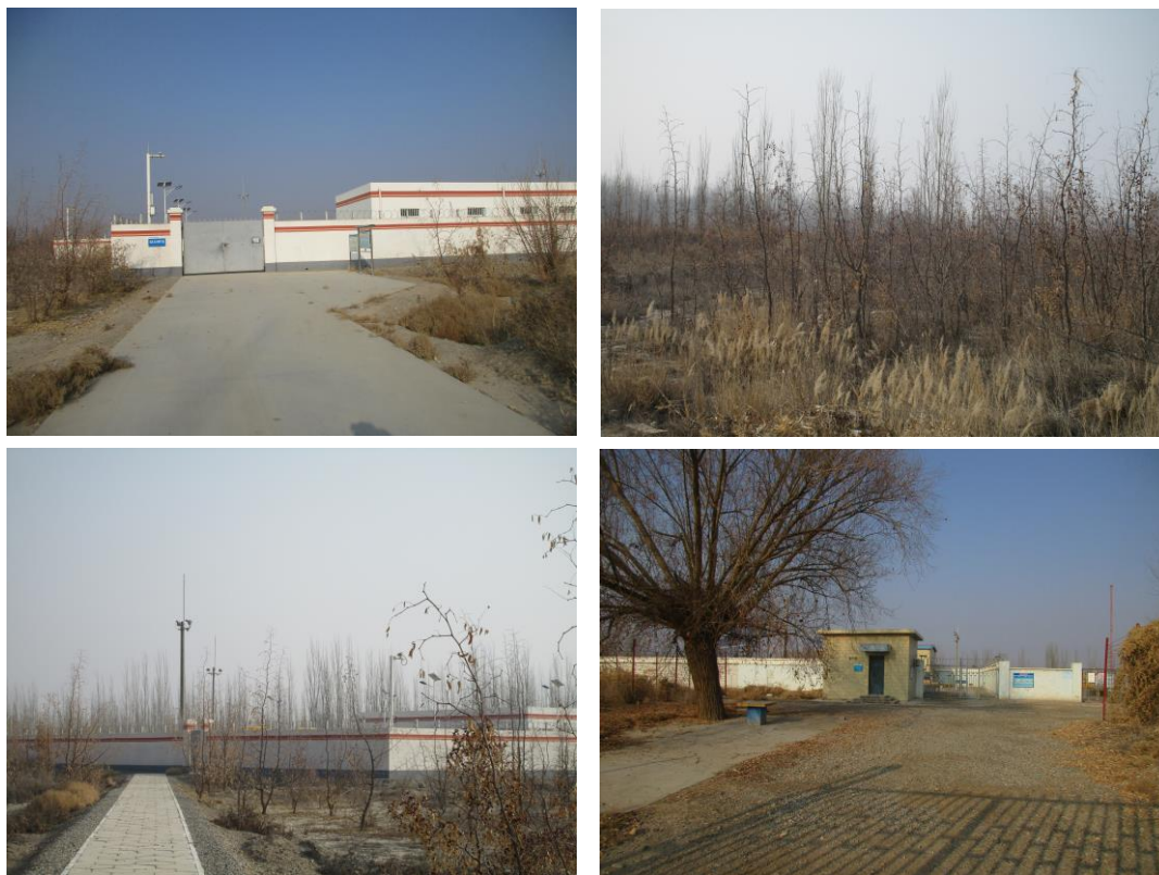
图 7-3 同类管道站场工程生态保护及恢复措施
