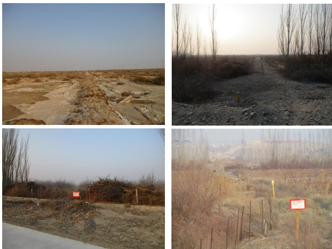
图 7-2 同类管道开挖工程生态保护及恢复措施
