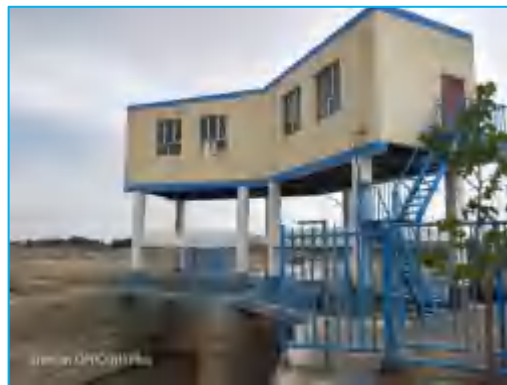
进、分水闸及闸房
