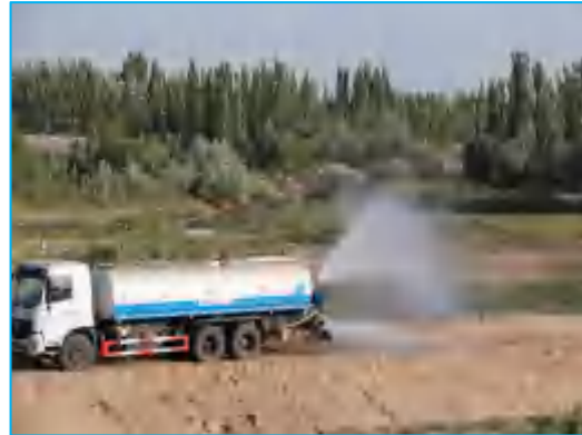
施工防尘措施
