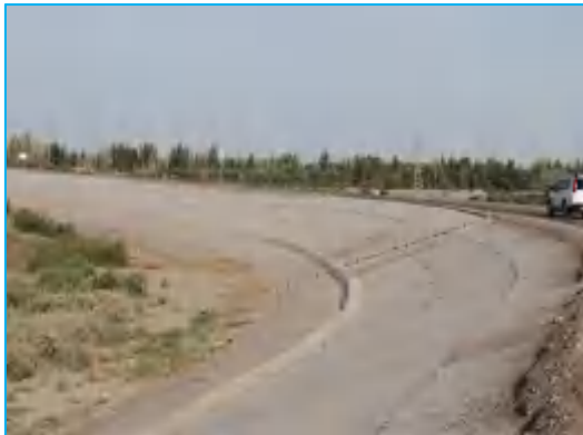
水库坝坡加固现状
