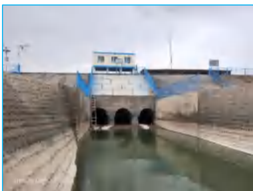
三孔泄水闸及闸房
