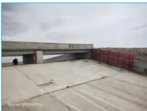
开敞式非常溢洪道
