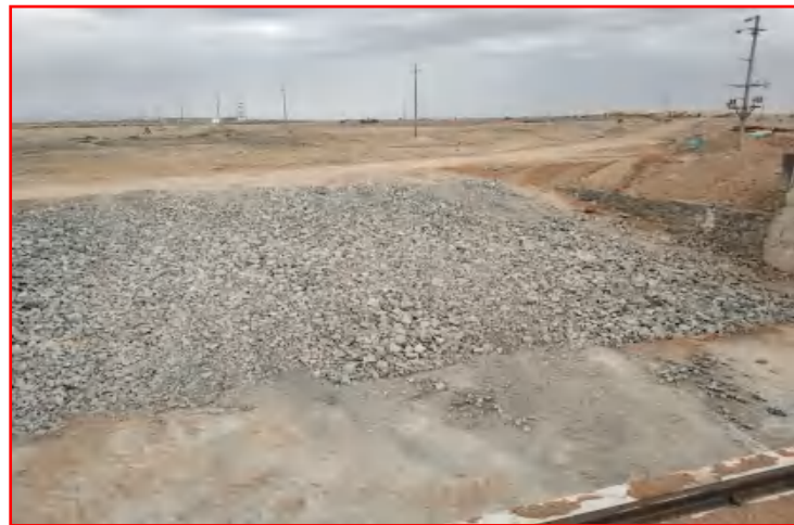
废石垫铺工业场地
