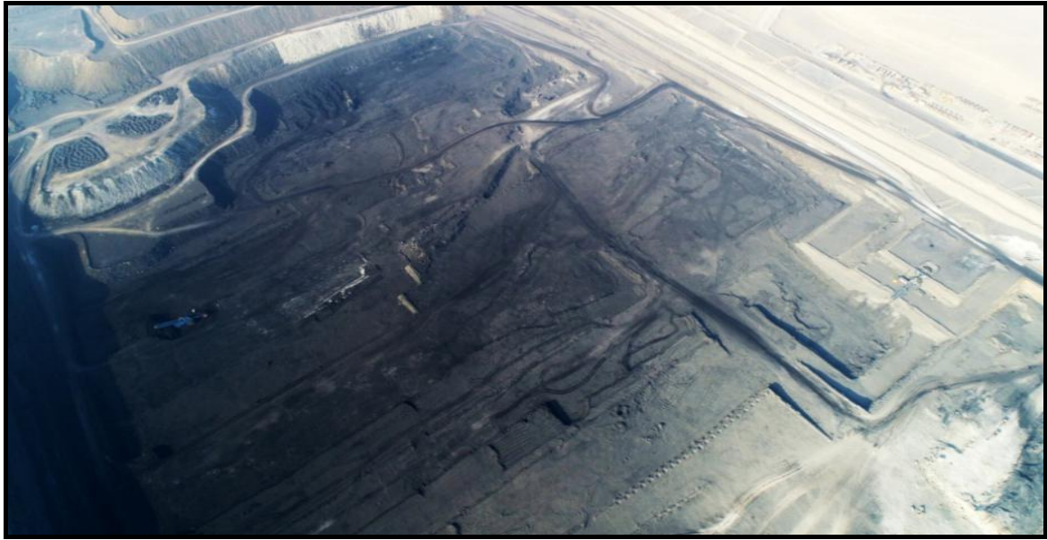
图 3.2-11 安全隐患治理工程现状
