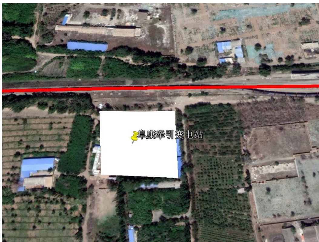
阜康新建牵引变电站
