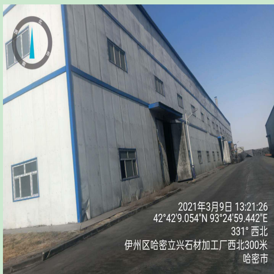
项目区西侧厂房
