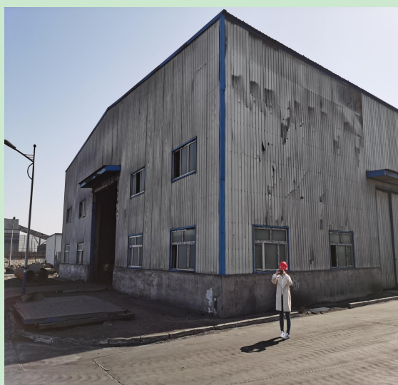
项目车间内现状
