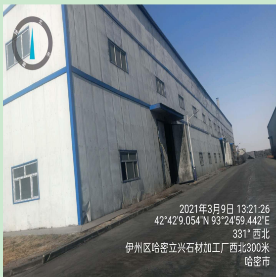
项目区西侧仓储库房
