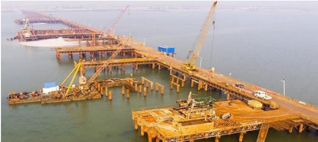
图 3.1-5 施工钢栈桥
