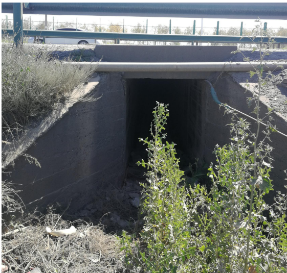
钢筋砼盖板涵
