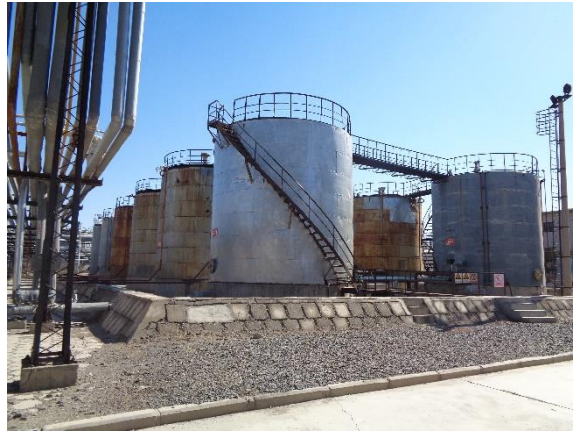
现有馏分油储罐区
