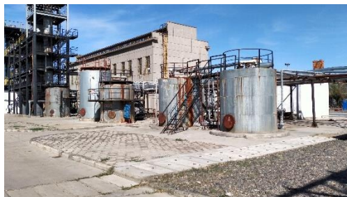
现有酒精罐区
