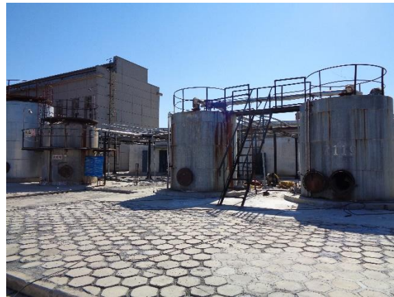
现有酒精罐区
