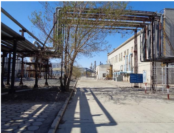
现有厂区已建道路
