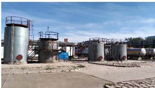
现有液碱罐区
