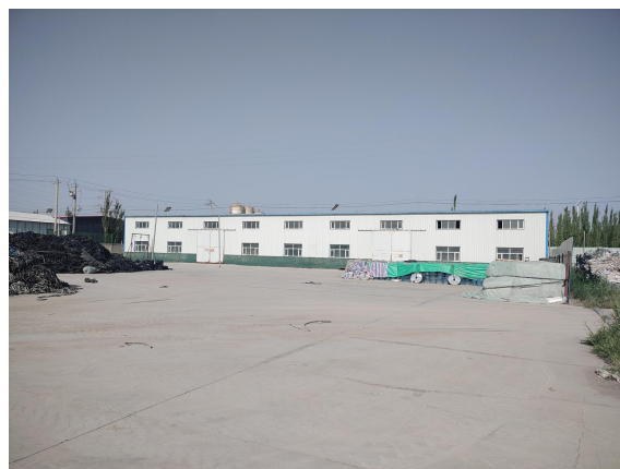
项目区北侧新疆源水科技开发有限公司
