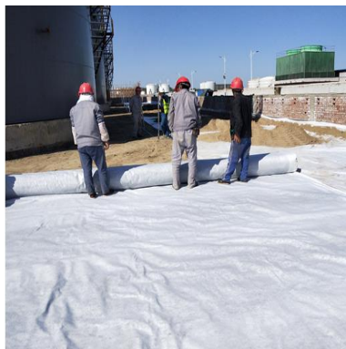
储罐围堰区域防渗膜铺设
