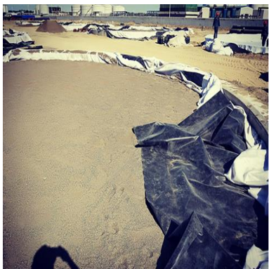
罐区基础防渗膜铺设
