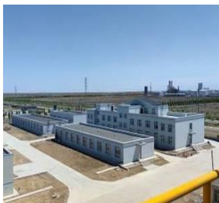
办公楼、食堂及宿舍
