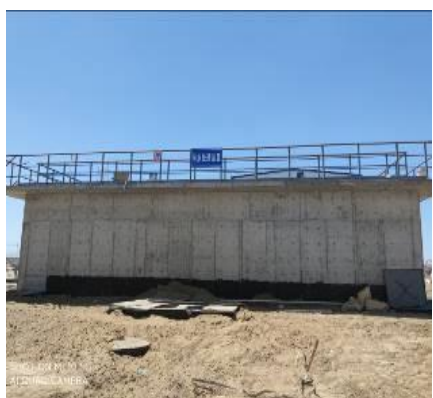
污水处理设施
