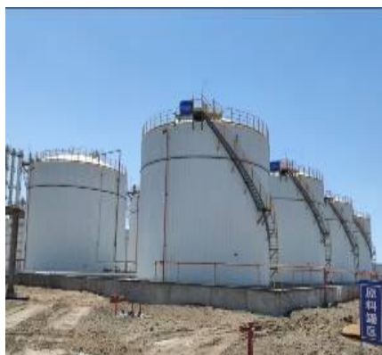
原料储罐罐区
