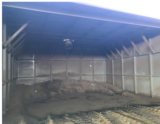
还原土暂存间（上部）
