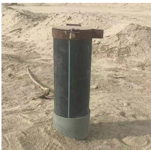
地下水监测井
