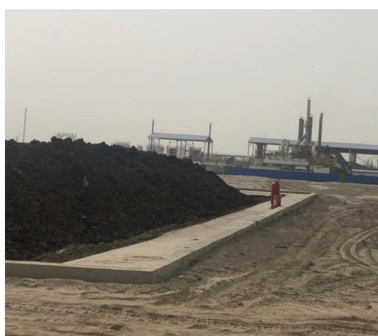
污油泥存储现状
