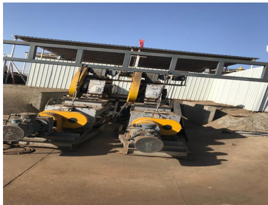
还原土暂存间喷淋降尘措施
