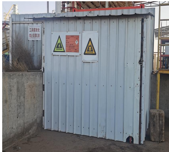
危险废物暂存间
