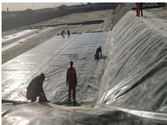
储存池土工膜铺设
