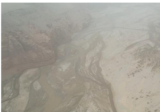
下游河滩料场、3#利用料堆放场实景照片
