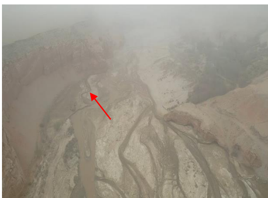
电站厂房区实景
