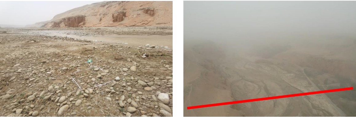
策勒河昆仑水利枢纽工程坝址区实景
