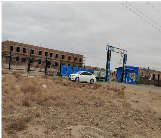
项目区东侧：在建新疆北庭希望环保科技有限公司
