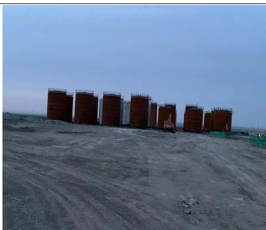
项目区现有工程储罐区
