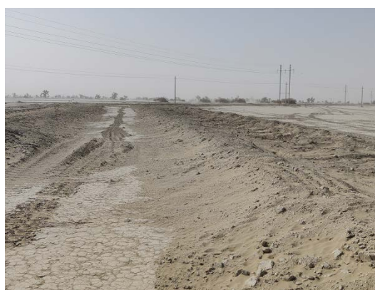
单井集输敷设完成,地表尚未恢复
