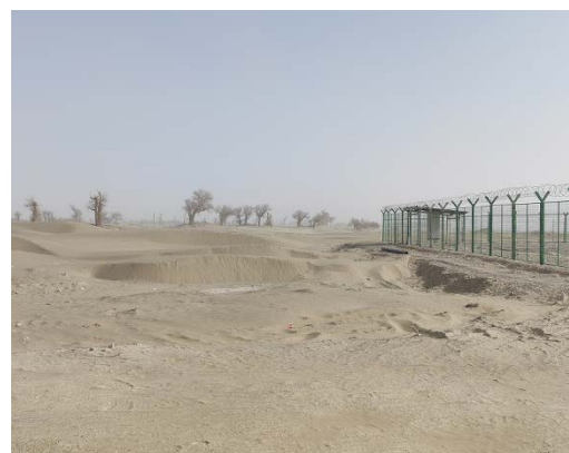
富源 3 阀组站外未实施防风固沙
