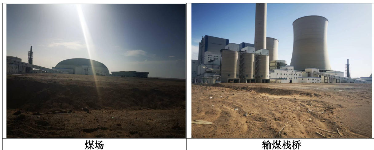
图3-1-2 现运行煤场实景图
