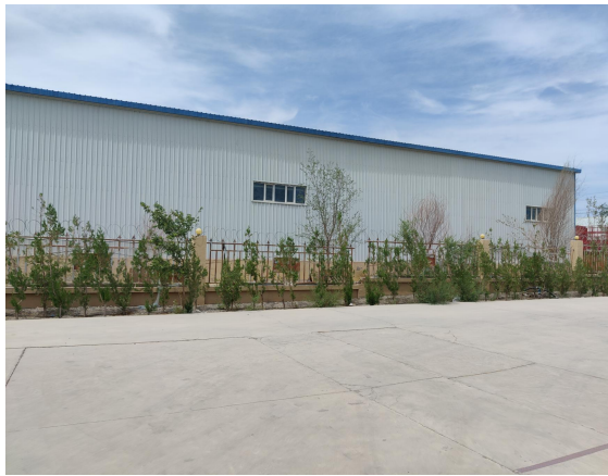
西侧哈密四通科技有限公司厂房
