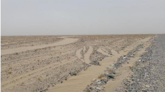
3#道路料场实景照片
