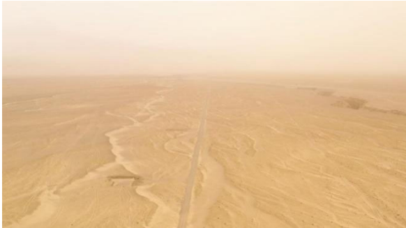
永久进场道路实景
