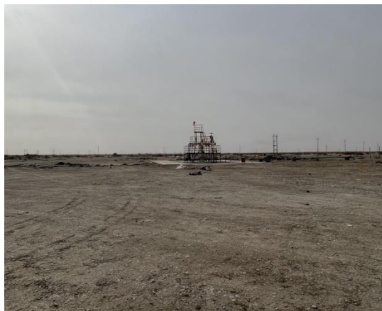
井场砾石铺垫措施
