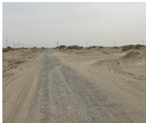
井场道路情况
