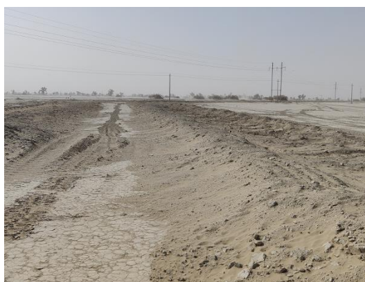
现有单井集输敷设完成,地表尚未恢复 富源东 2 号计转站周围有施工垃圾
