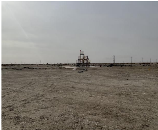
井场砾石铺垫措施
