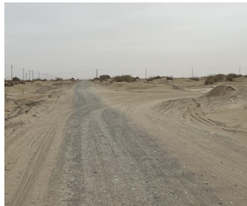
井场道路情况
