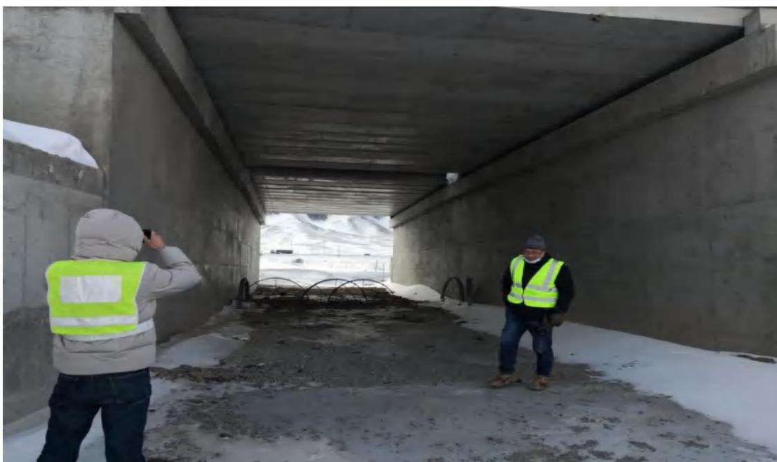
图 6.24 K63+407 孔径 6×7m 的桥梁完全可以作为野生动物通道
