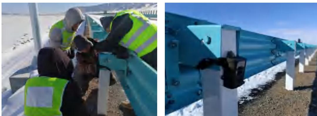
K67+160 处（右侧）平基式动物通道红外相机安装情况
