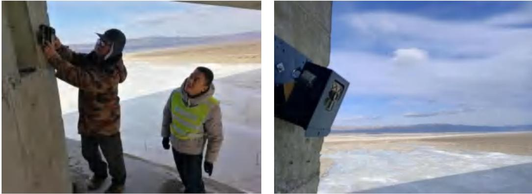
图 6.21 K42+765 处桥梁式动物通道红外相机安装情况
