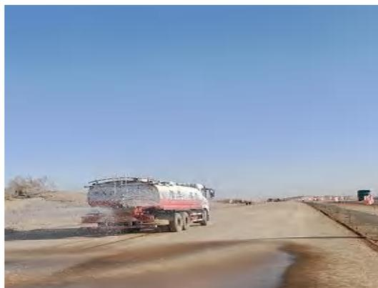
图 8.2 施工便道洒水抑尘
