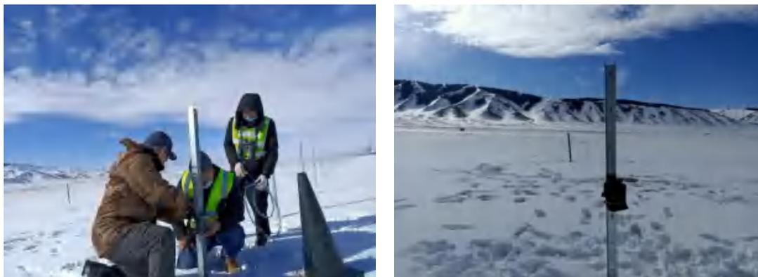
K67+160 处（左侧）平基式动物通道红外相机安装情况
