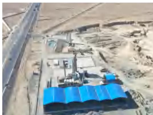
图 8.1 拌合站密闭拌和、料仓封闭
