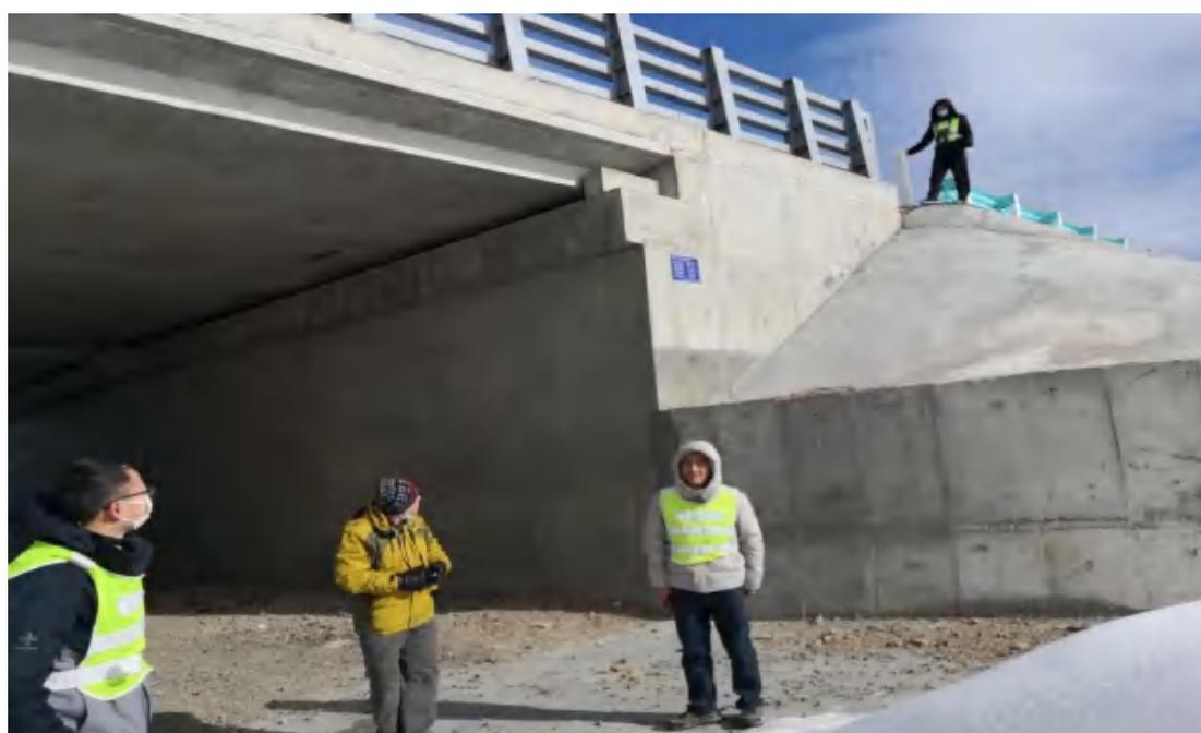
图 6.25 K65+630 孔径 6×7m 的桥梁完全可以作为野生动物通道
