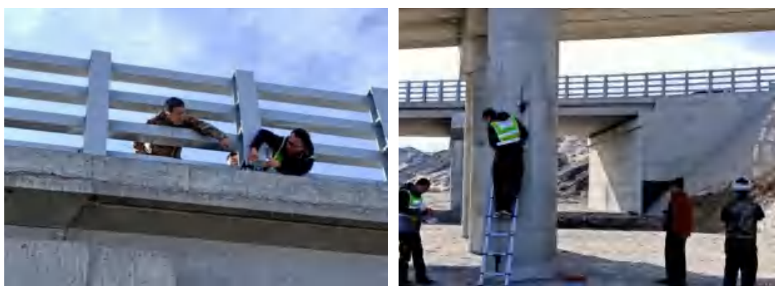
SK89+641.40 桥梁式动物通道现状及红外相机安装情况
