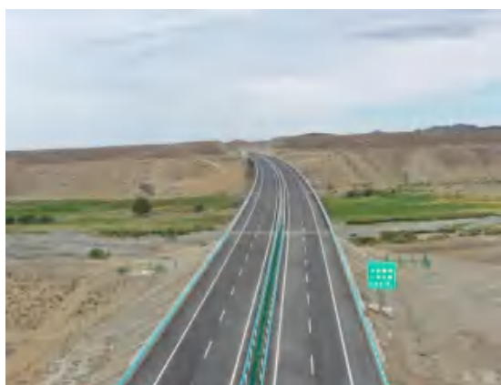
K175+468 大白杨沟 2 号大桥
