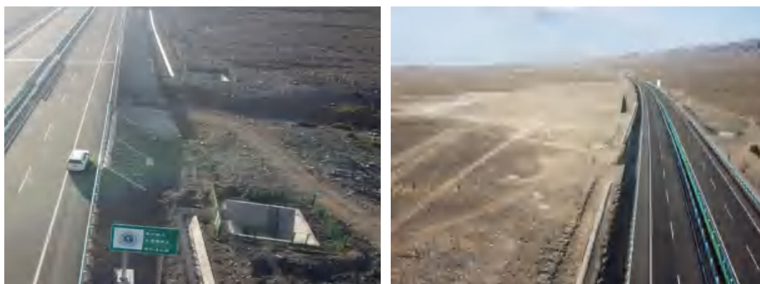
K185+085 伊吾河 1 号大桥径流收集系统、事故池与防撞护栏
