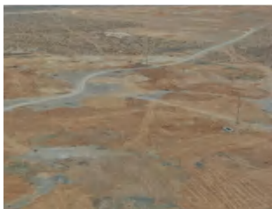
SK27+800TJ-1 标项目部、拌合站、 梁场、预制场、钢筋加工厂等已经恢复
