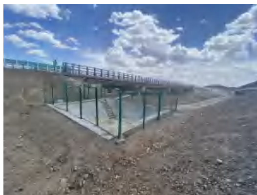
SK59+733 图拉尔根河中桥径流收集系统、事故池与防撞护栏
