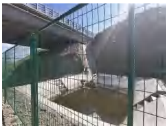
K174+375 大白杨沟 1 号大桥径流收集系统、事故池与防撞护栏
