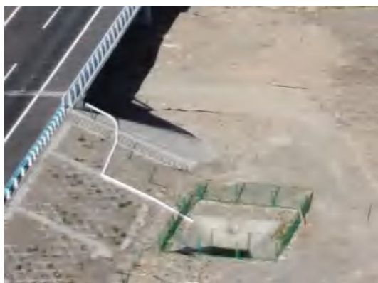
K175+468 大白杨沟 2 号大桥径流收集系统、事故池与防撞护栏
