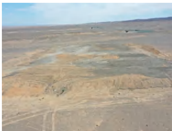
SK114+000 拌合站已实施土地平整
