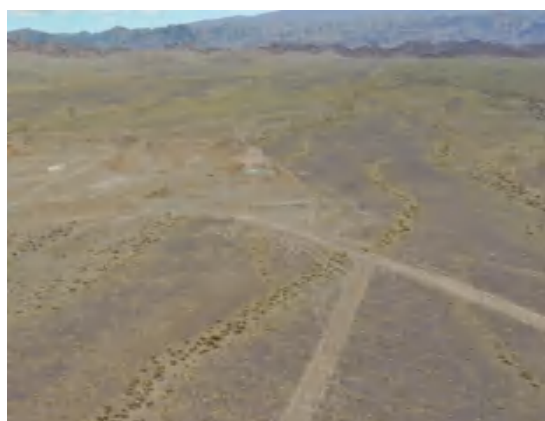
取土场施工便道
