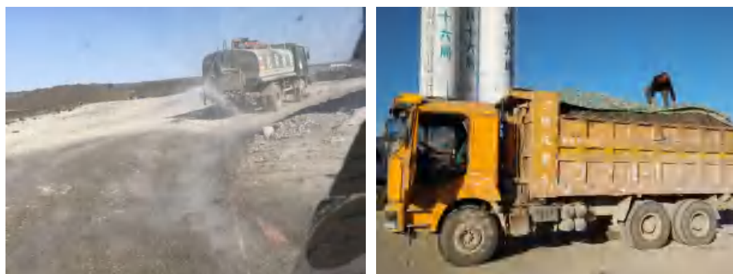
图 8.2 施工便道洒水、运输车辆苫盖
