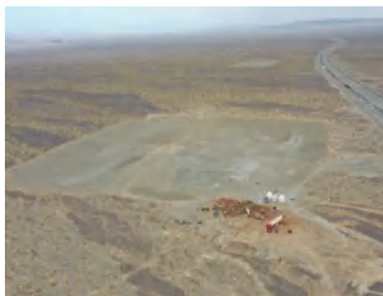
K146+800 水稳拌合站已恢复
