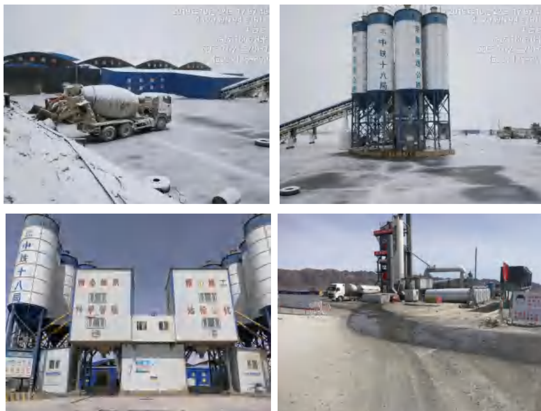
图 8.1 拌合站密闭拌和、料仓封闭
