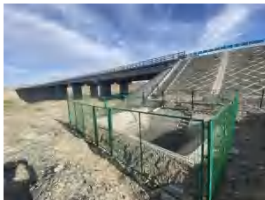
K175+468 大白杨沟 2 号大桥径流收集系统、事故池与防撞护栏
