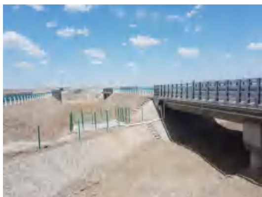
SK59+733 图拉尔根河中桥径流收集系统、事故池与防撞护栏
