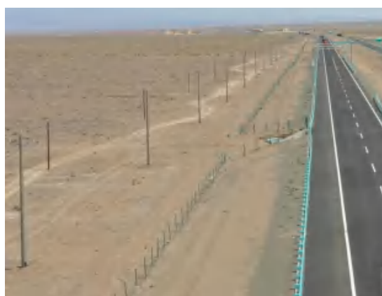
主线伴行施工便道
