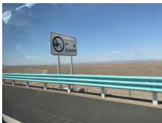
K95+500 处严禁乱扔弃物警示牌
