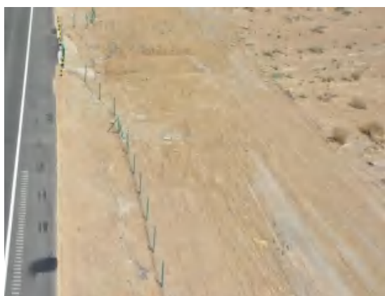
主线伴行施工便道
