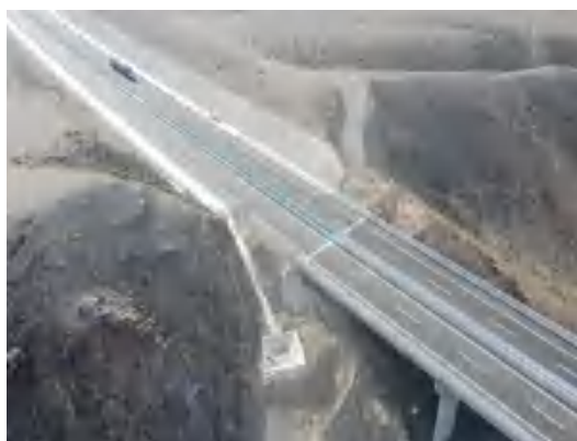
K174+375 大白杨沟 1 号大桥径流收集系统、事故池与防撞护栏
