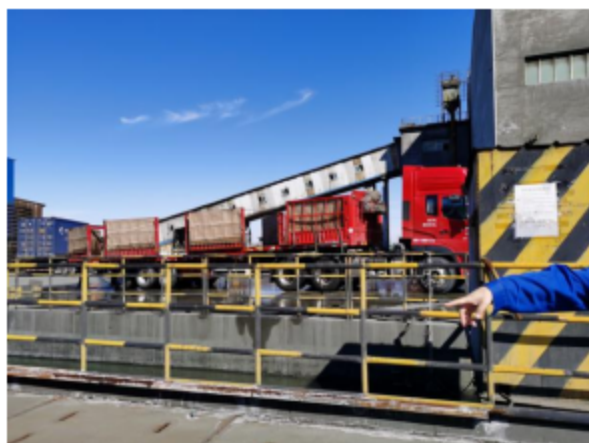
车辆清洗废水沉淀池
