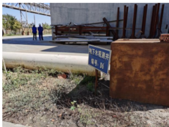
地下水观测井
