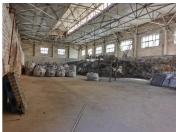
拟存储氰化渣的铅滤饼库
