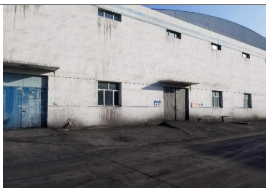
含煤废水处理车间
