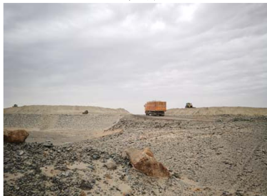
原灰场运灰作业
