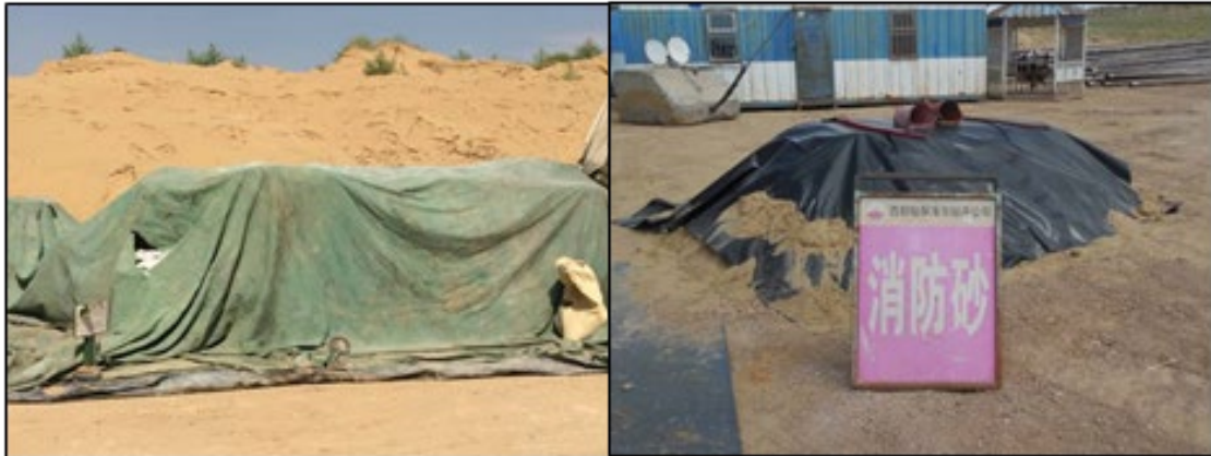
油田常用钻井井场防尘布遮盖示例
