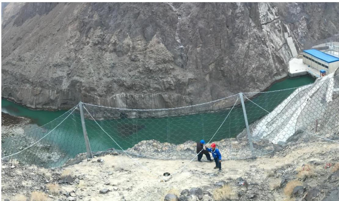
图 4.2.4 开挖后柳树沟坝下尾水河道现状
