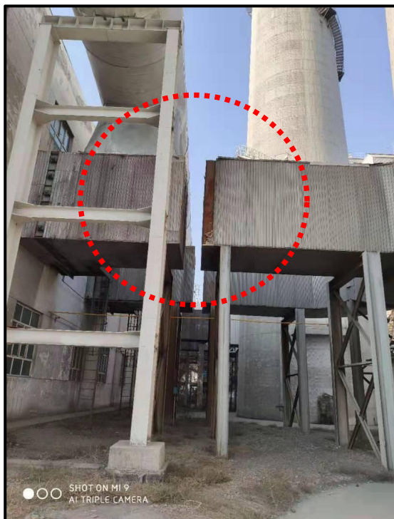
220t/h 燃气锅炉烟道断开点
