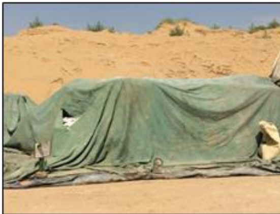
油田常用钻井井场防尘布遮盖示例
