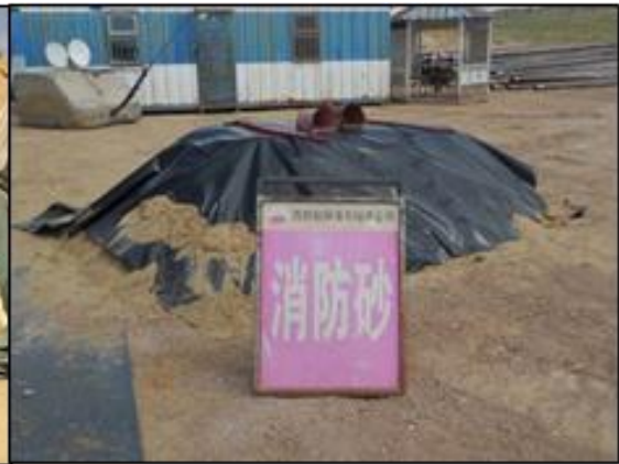
油田常用钻井井场消防砂防尘措施示例
