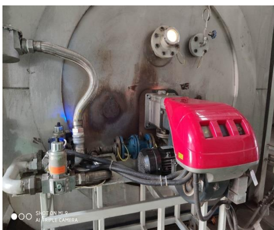
热解炉配套燃烧机
