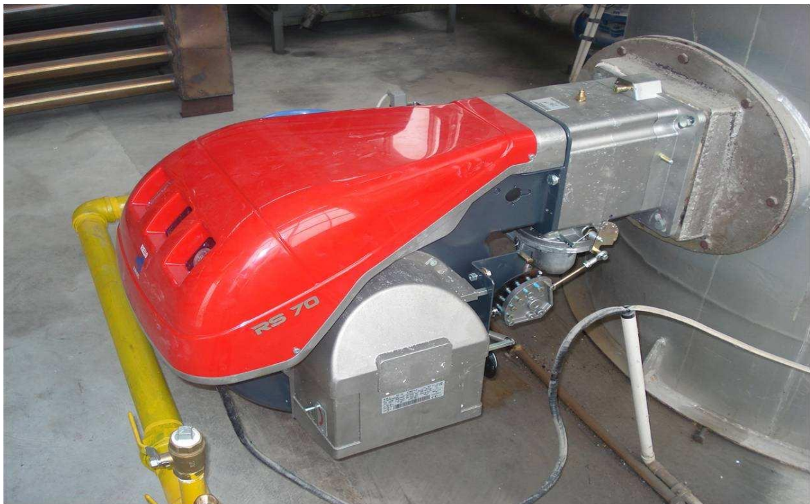
图 6.2-1 在燃烧设备上安装的利雅路燃烧器实例
