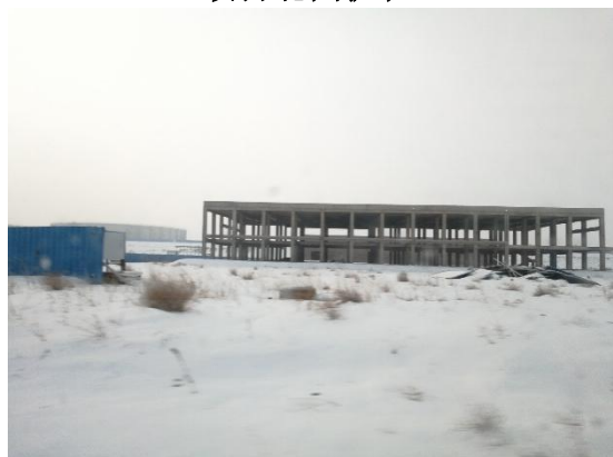
煤制油项目在建工程 (1)
