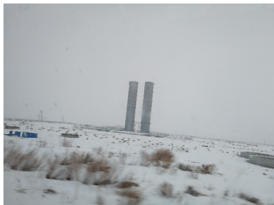
煤制油项目在建工程 (3)
