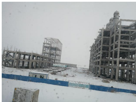
煤制油项目在建工程 (2)
