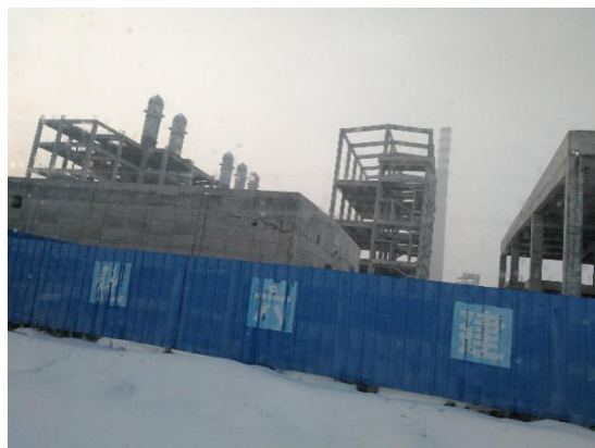
煤制油项目在建工程 (4)
