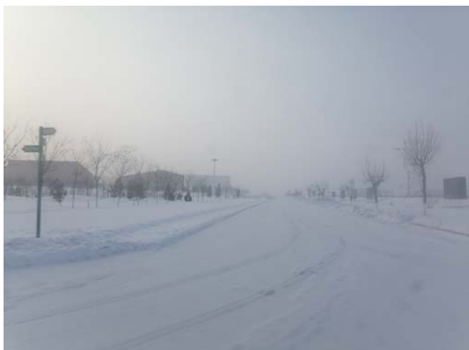
现有工程道路现状
