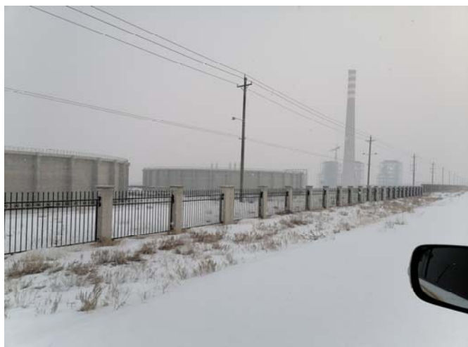
项目区西北方向现有装置区
