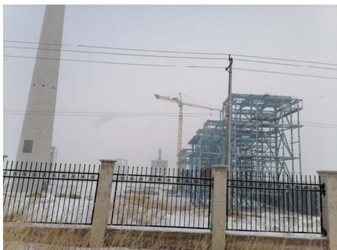
现有工程建设现状
