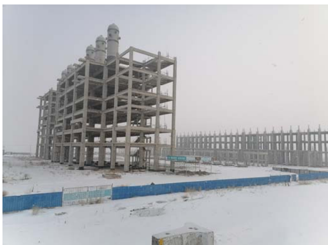
现有工程建设现状
