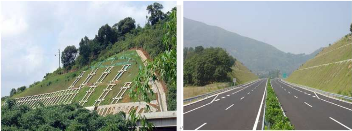
图 3.1-5 挖方段路基防护示意图
