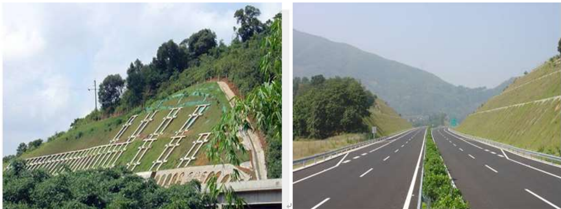
图 3.1-5 挖方段路基防护示意图
