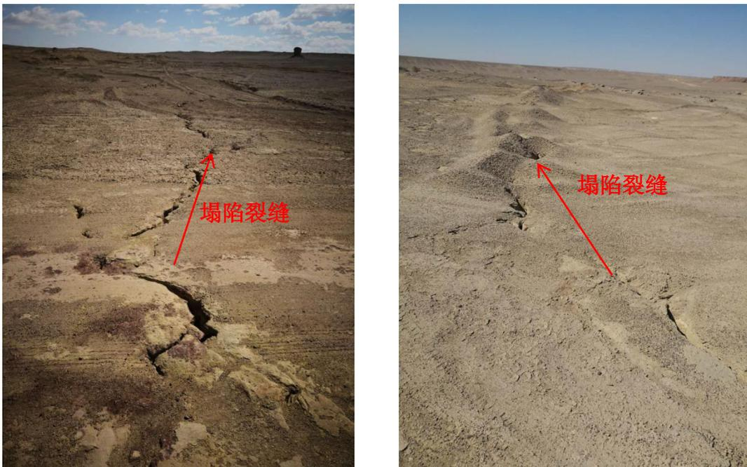
图 3.1-1 采空塌陷形成的裂缝现状照片
