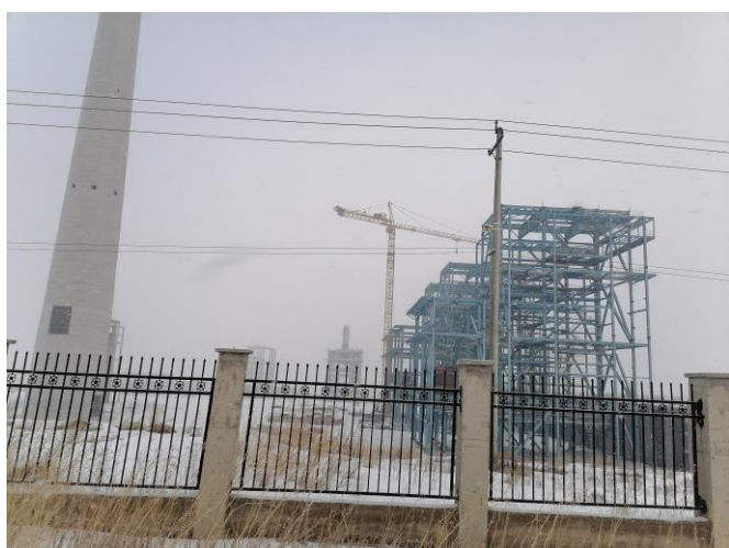
现有工程建设现状
