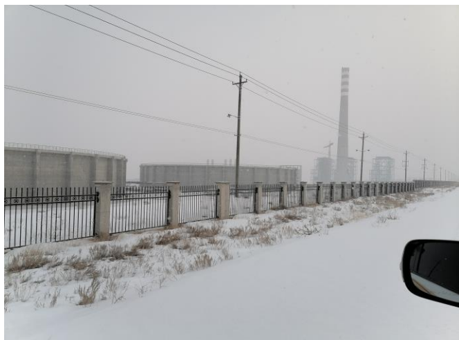
项目区西北方向现有装置区
