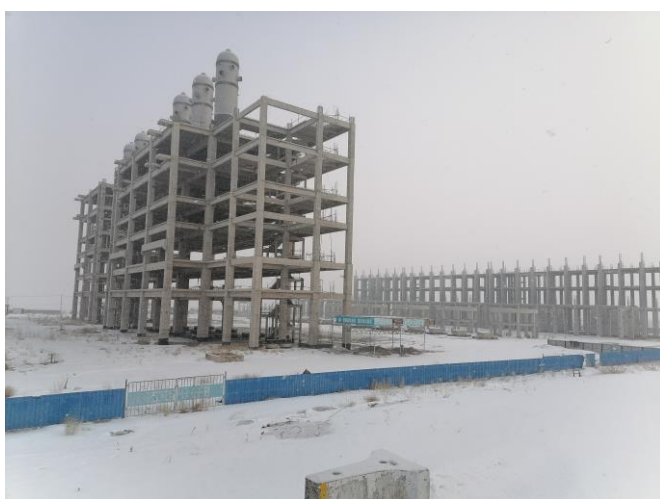
现有工程建设现状
