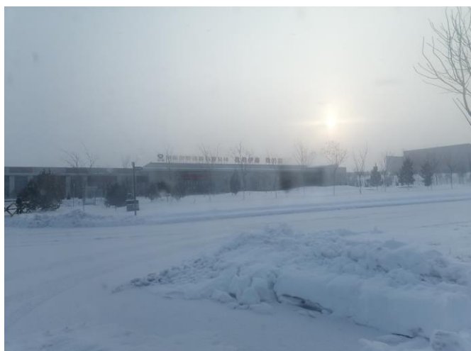
现有工程建设现状
