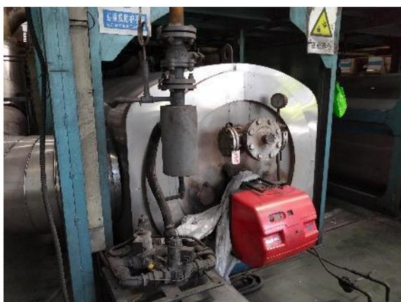
裂解炉配套燃烧机
