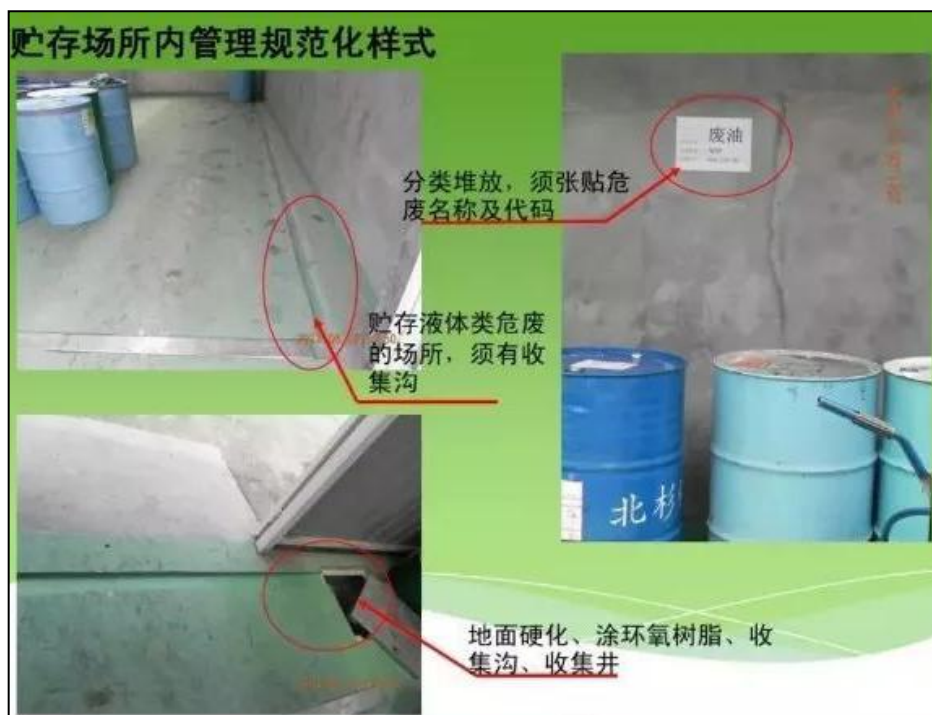
图 6.6-2 地面导流及收集槽样式
