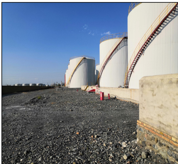
项目罐区及周边路面
