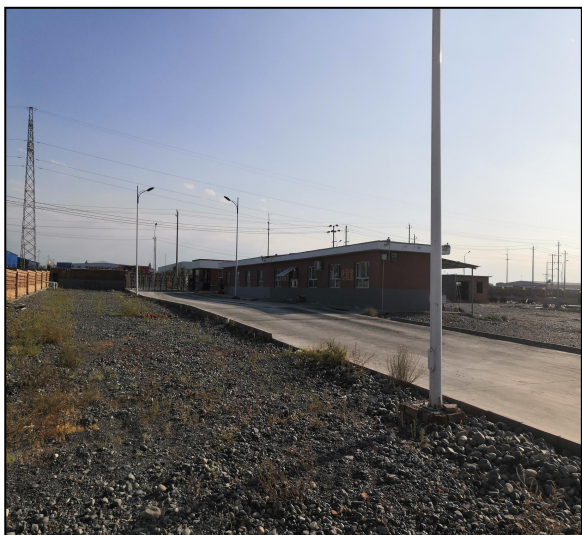
厂区门卫室、化验室和沥青操作室
