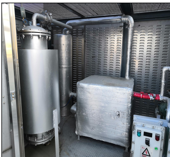
改性沥青预混罐、发育罐、中间罐
