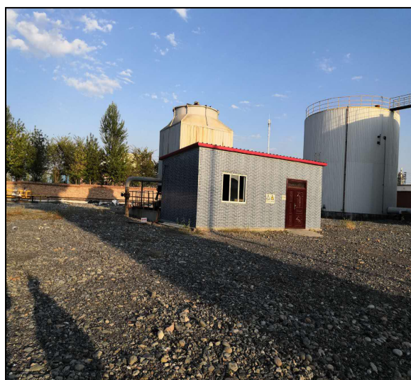
循环水泵房及消防水罐
