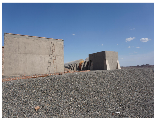
废石用于铺垫工业场地
