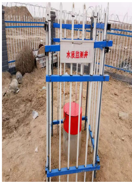
地下水监测井
