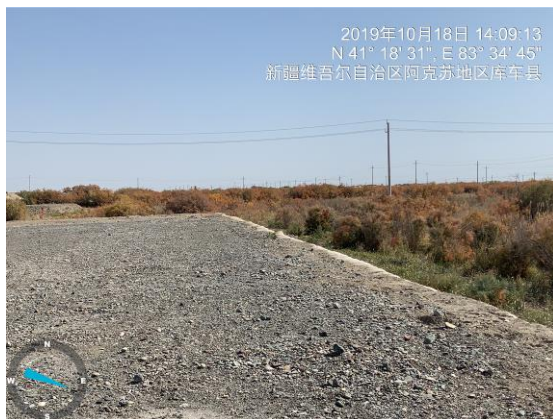
井场恢复情况
