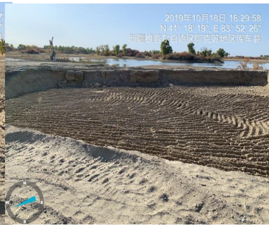
井场临时占地平整
