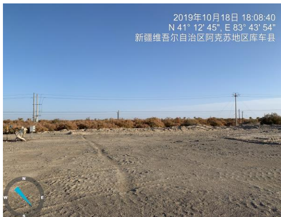
井场附近供电线路
