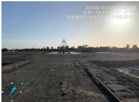
勘探井口场地恢复情况
