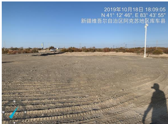
井场前方进场道路
