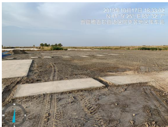
井场恢复情况
