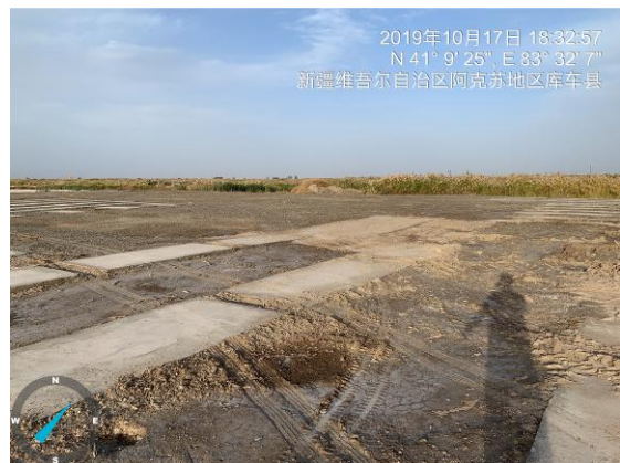
井场恢复情况
